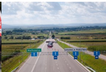
Inauguracji prac przy budowie przejścia granicznego w Malhowicach
