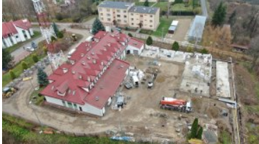
Placówka Straży Granicznej w Hermanowicach w trakcie przebudowy
