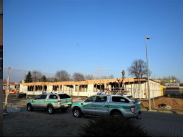
budowa strzelnicy w komendzie BiOSG
